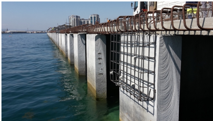
Foto 2: Construcción muelle con tecnología NOWAVES, ventanas exteriores y superestructura
