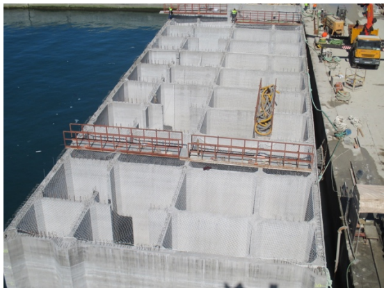
Foto 1: Construcción cajón con tecnología NOWAVES
